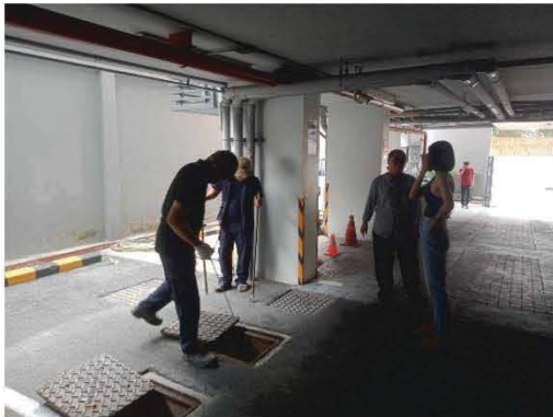
สูบตะกอนระบบบำบัดน้ำเสีย (02/02/66)
